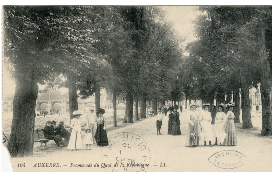
Promenade du quai de la République Arch. Dép. Yonne, 2 Fi 711
