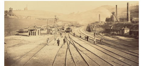
La gare de triage du Pont-de-l'Âne à Saint-Etienne (Collard, 1865)
