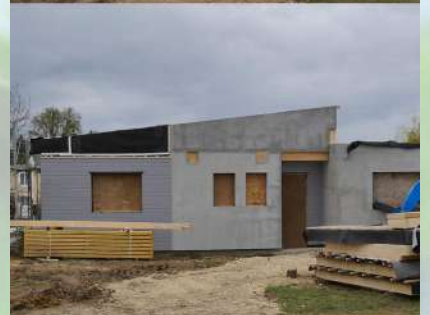
Evolution en deux jours de la construction d'une maison à ossature bois proche de notre école.
