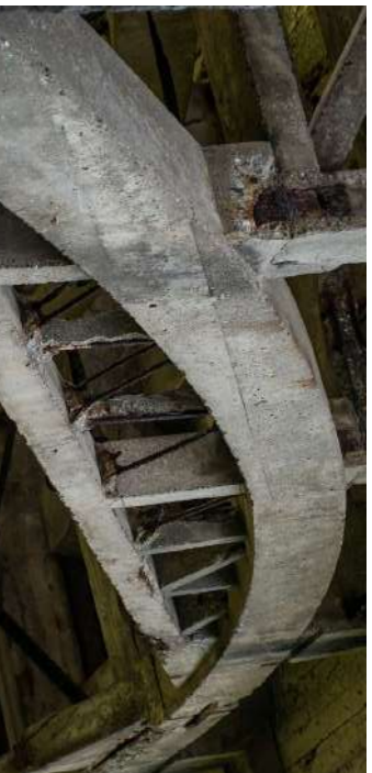
Viaduc de Caroual (Côte d'Armor) :
