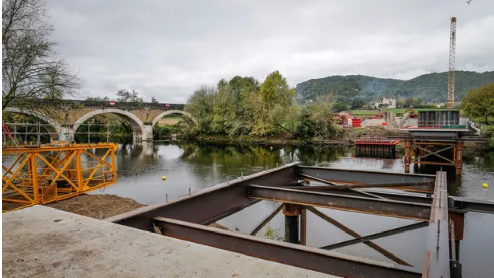
Les parties déjà construites par le département de la Dordogne devront être démolies et le site remis en état. THIBAUD MORITZ / AFP
