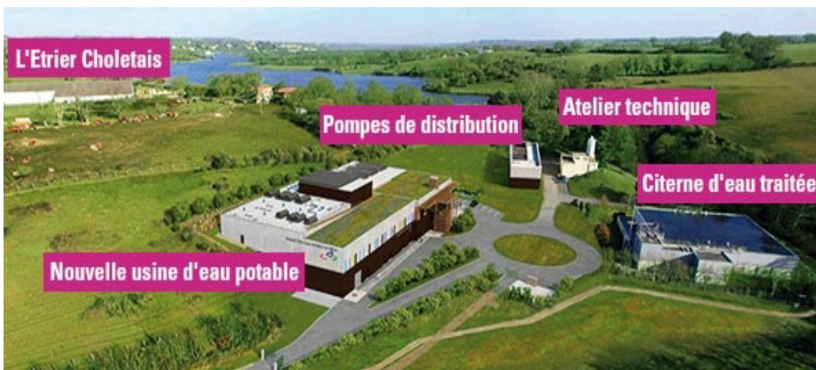
Nouvelle usine d'eau potable de Ribou © KASO – atelier d'architecture, cholet.fr
