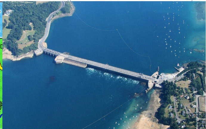
Barrage de la Rance
