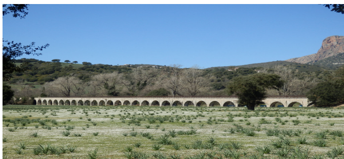
Canal de la Gravona près de l'école (Photo école)
