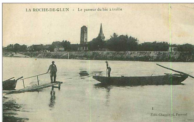
Le bac à traîle était une embarcation utilisée pour traverser le Fleuve, qui se déplaçait le long d'un câble (la traîle), tendu entre les deux rives. Il avançait en utilisant la force du courant et en ramant.
