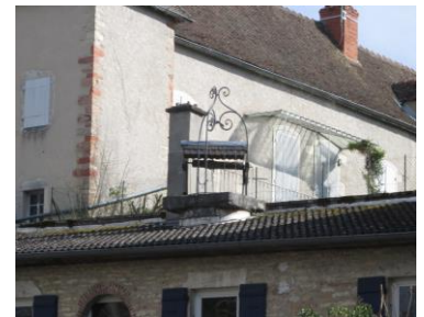
Le puits sur le toit de Dracy- Le-Fort.
