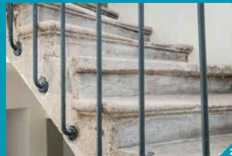
**2. L'ensemble de la structure a pu être respecté ainsi que les aménagements intérieurs notamment la cage d'escalier en béton moulé et son garde-corps en fer forgé**
