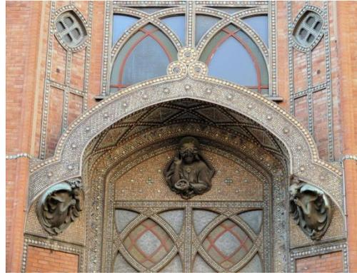
En raison de la pente du terrain, l'édifice est constitué de deux sanctuaires superposés : l'église basse, crypte ouverte sur la rue. L'église haute de plan classique (croix latine) est caractérisée par ses « arcs enlacés » gothicisants. La technique du « béton Cottencin » repose sur le principe de poteaux en briques enfilées sur des tiges de fer portant des réseaux métalliques recouverts de ciment fin qui constituent le couvrement.
