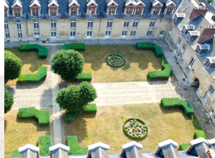
Cour des offices
