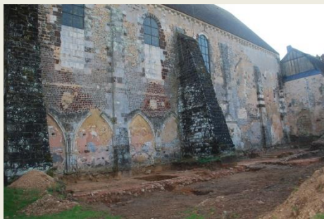
Vue des fouilles archéologiques réalisées avant le début des travaux de restauration du mur Nord de l'Abbaye.
