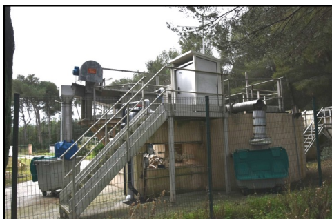
Vue de la station
