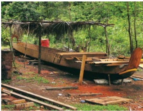
Maripossani (Guyane). Chantier de construction de pirogues sur le Maroni. Les bordes vernies d'écorce de bois bala sur la coupe monotype ouverte au feu.
