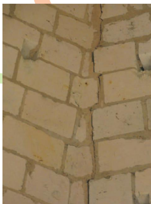
L'intérieur de la flèche et un détail des fissures Clichés A de Saint-Jouan
