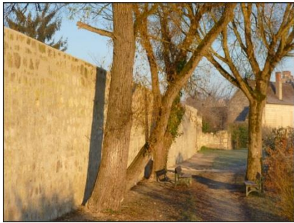
Mur d'enceinte (restauré en 2012/2013) © Mairie de Beaulieu-lès-Loches
